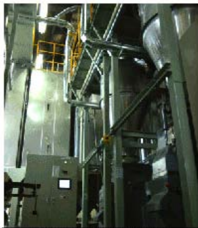
設備更新をした精米所
